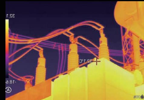
变压器高压套管
